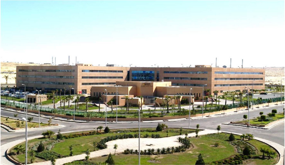
Abbildung 4: Hörsaalkomplex A (Vordergrund) und Gebäudekomplex B (dahinter) – Fertigstellung Ende September 2003
