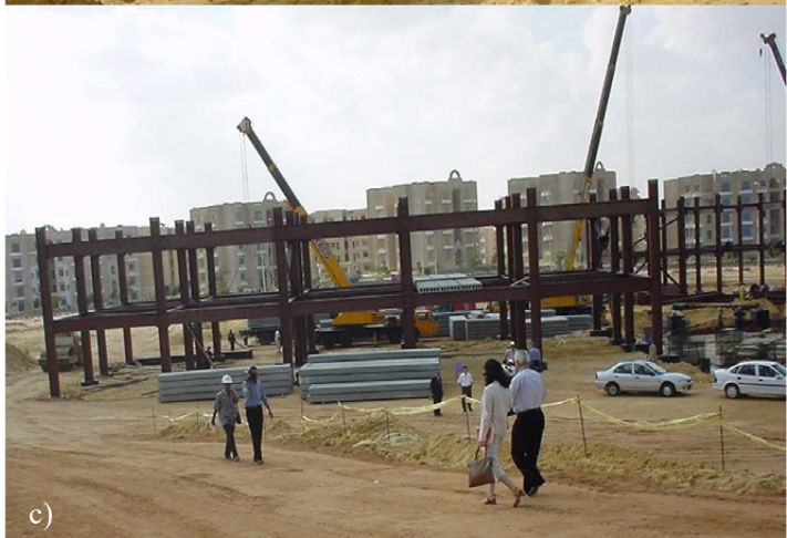
Stahlskelettbauweise Gebäudekomplex B (c)
